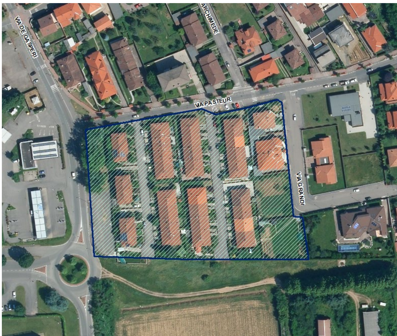
Figura 8 - Area interessata da allagamenti in Via Pasteur/Via De Gasperi
