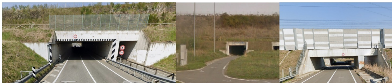
Figura 11 - Sottopassi di Via Varese, Pista Ciclopedonale e Via Mendrago
