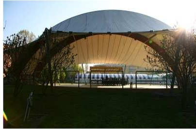
La tensostruttura, all'interno del Parco Ghiotti, realizzata nel 2002 copre una superficie di circa 1000 mq. La struttura è realizzata in legno lamellare. La tensostruttura è regolarmente utilizzata per tutte le manifestazioni comunali come concerti e spettacoli.
