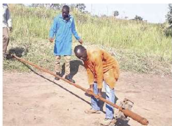
Alcuni operai del villaggio piazzano le pompe per attivare i pozzi dei missionari
